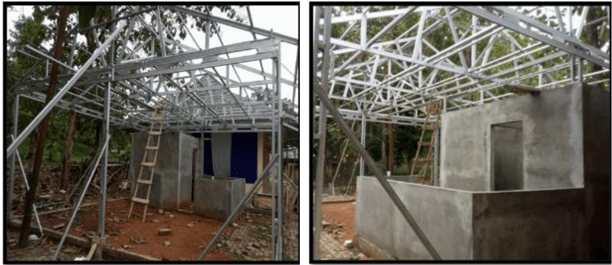
Gambar 2. Pembangunan Kafe Kampoeng Tahap 1
