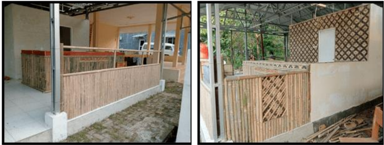
Gambar 3. Pembangunan Kafe Kampoeng Tahap 2
